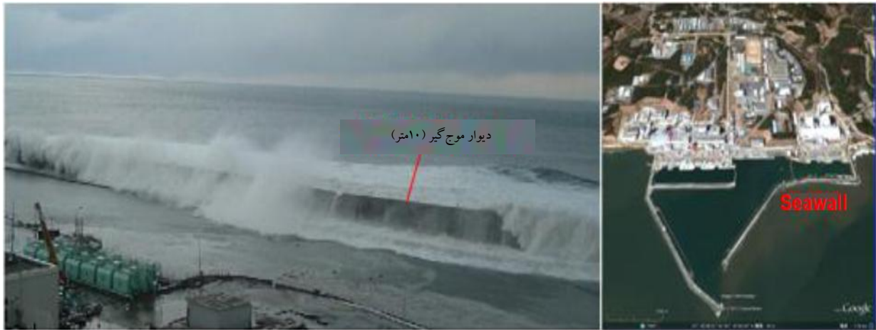
شکل ۳. عبور امواج دریا از دیوارهای ۱۰ متری محافظ نیروگاه که منجر به وارد شدن آسیب به تأسیسات مهم نیروگاه فوکوشیما-دایچی شد [۲].
